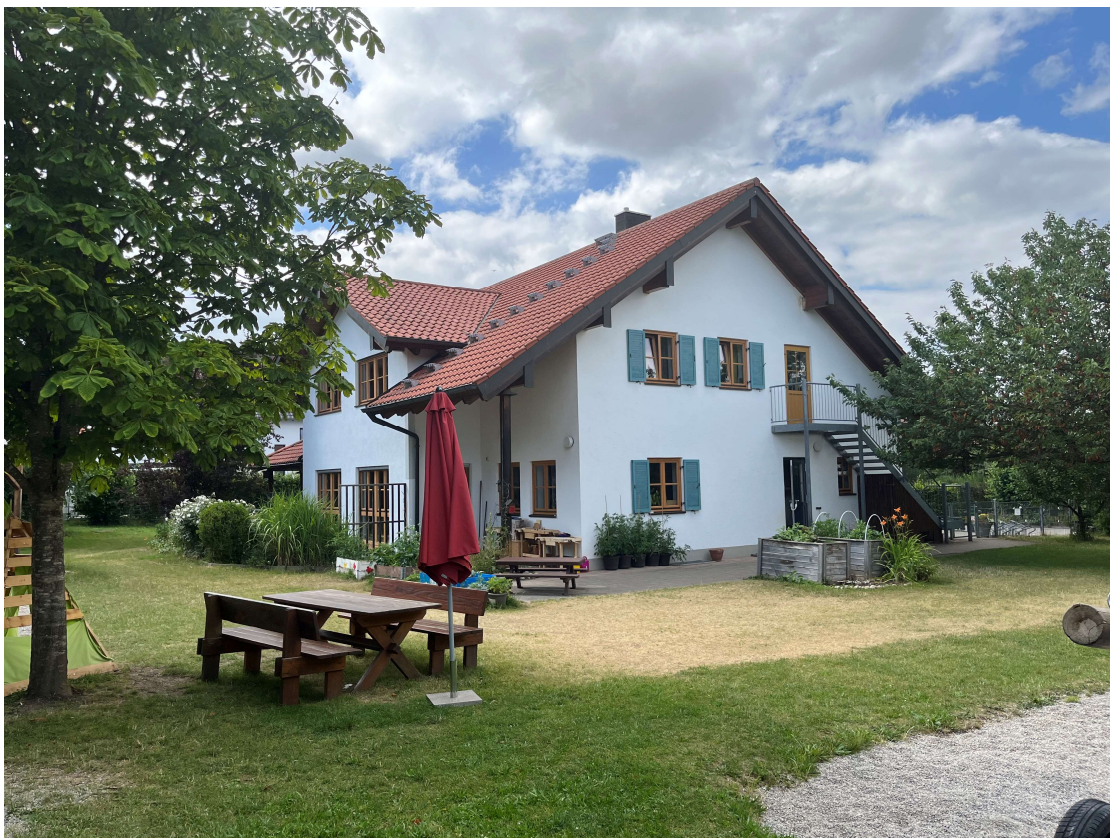
bestehender Kindergarten von Südosten
